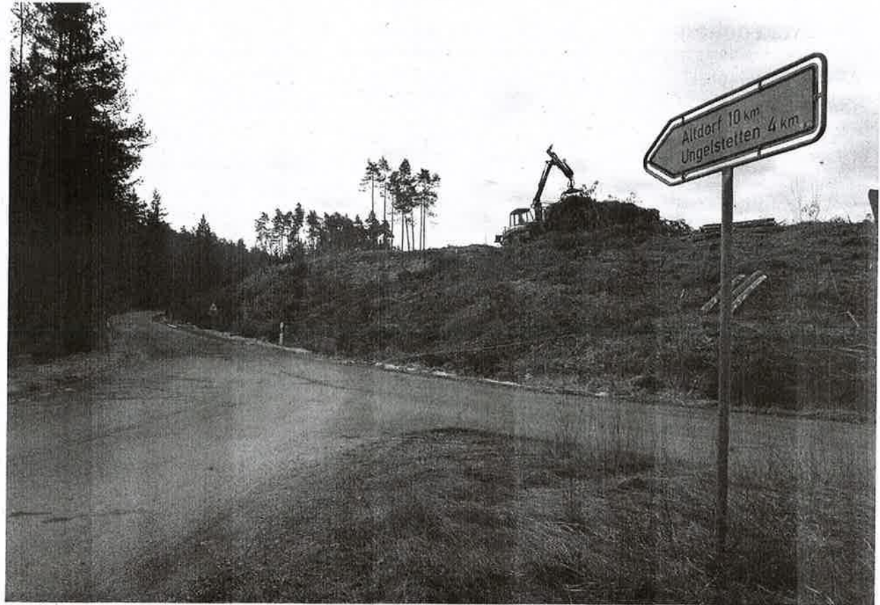
Umfangreiche Rodungsarbeiten laufen derzeit an der Straße zwischen Fuchsmühle und Brunn.
